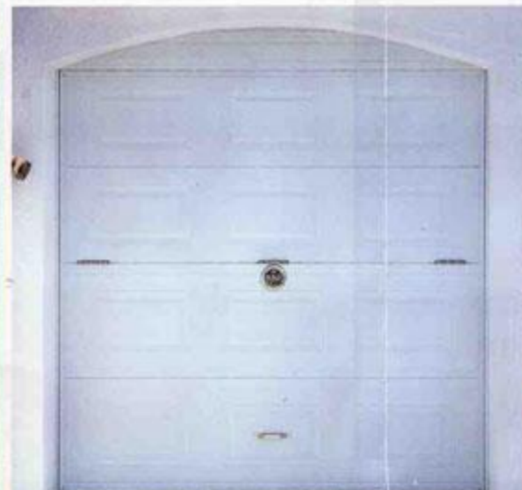
Porta basculant automàtica de dues fulles amb porta lateral de pas peatonal. Estructura de tub negre folrat en xapa de 3 mm, amb una mini reixeta superior de ventilació. L'acabat és modular.
