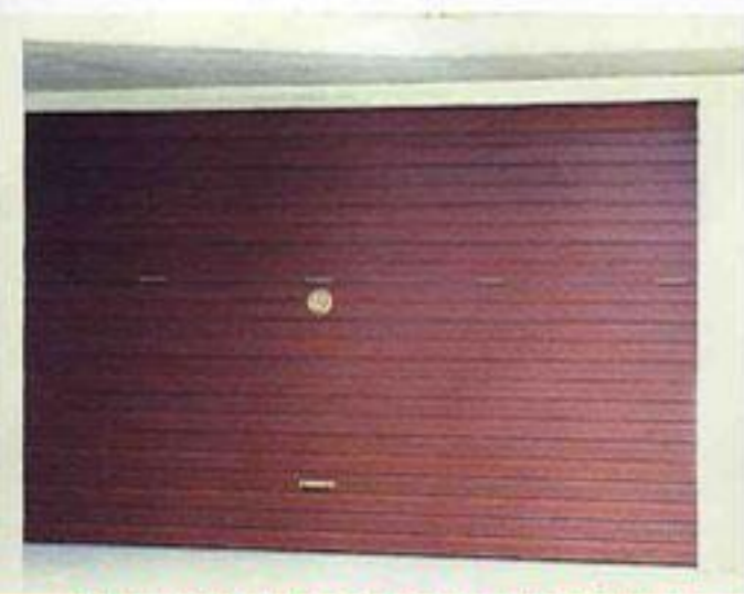
Porta basculant automàtica de dues fulles. Estructura galvanitzada folrada de xapa imitació fusta.
