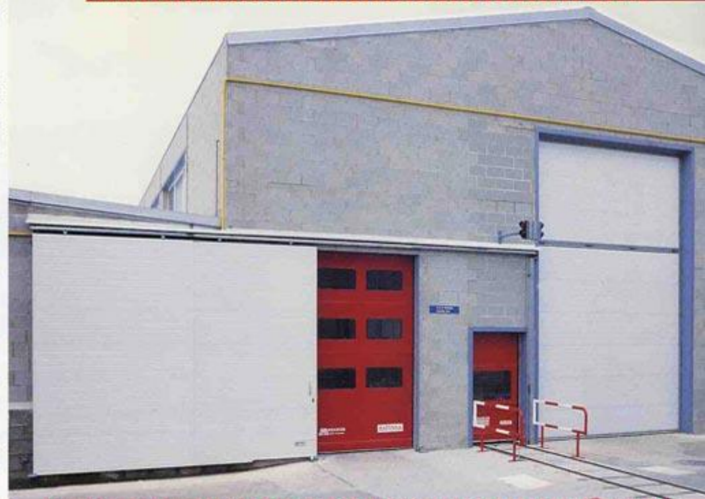
Conjunt de portes de tancament interior i exterior. En primer terme una porta corredissa i una porta basculant Industrial tipus sandvitx, ambdues folrades de doble xapa lacada blanca i amb poliuretà expandidit a l'interior. Van ser especialment dissenyades d'alta seguretat per al tancament de les obertures de les vies on s'ubiquen les portes ràpides de lona. Aquestes últimes són portes molt resistents a les indempències meteorològiques, i normalment es construeixen amb finestretes per a l'entrada de llum i per visibilitat.
