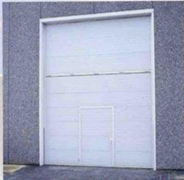
Porta basculant Industrial automàtica amb porta de pas peatonal incorporada. Està feta de doble xapa lacada blanca i amb poliuretà expandidit a l'interior, tipus sandvitx.
