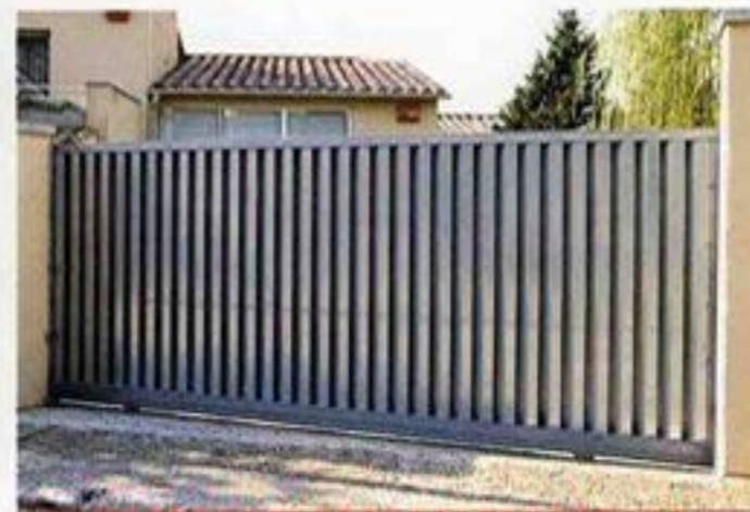
Porta corredissa automàtica feta de làmines verticals, tipus veneciana, galvanitzada i sense sòcol.
