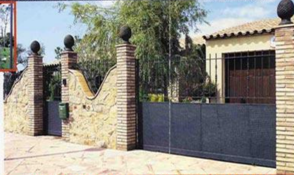
Conjunt de porta corredissa automàtica, porta de pas peatonal i tancament de reixes al voltant de tota la finca. Tot fet de forja i amb acabat segons disseny establert.
