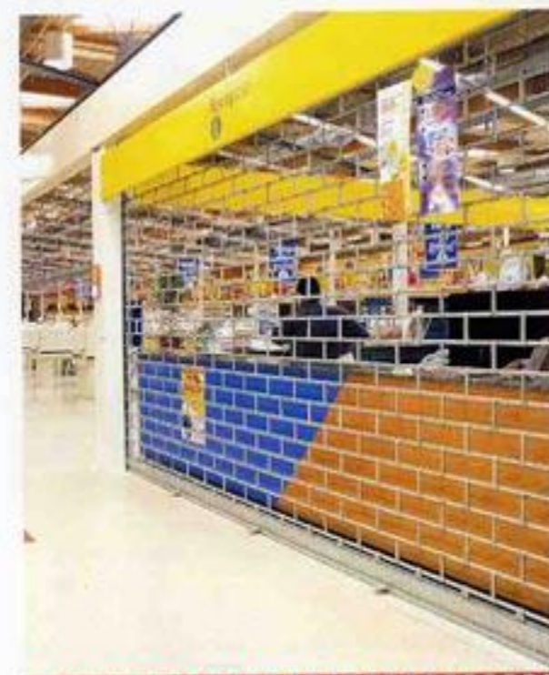
Portes enrotllables automàtiques tipus "rejol". La inferior és tubular de serie reforçada.
