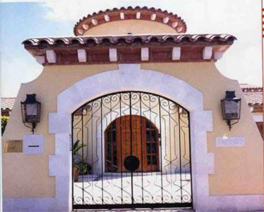
Porta practicable de doble fulla, de pas peatonal, feta de forja i amb acabat segons disseny establert.
