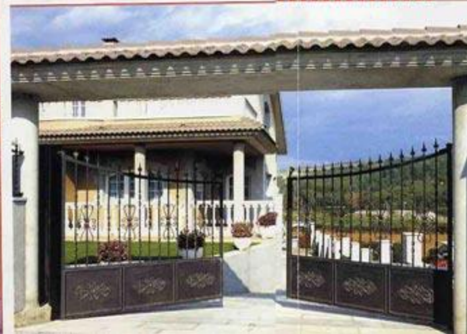
Porta practicable de doble fulla, de pas peatonal, feta de forja i amb acabat segons disseny establert.
